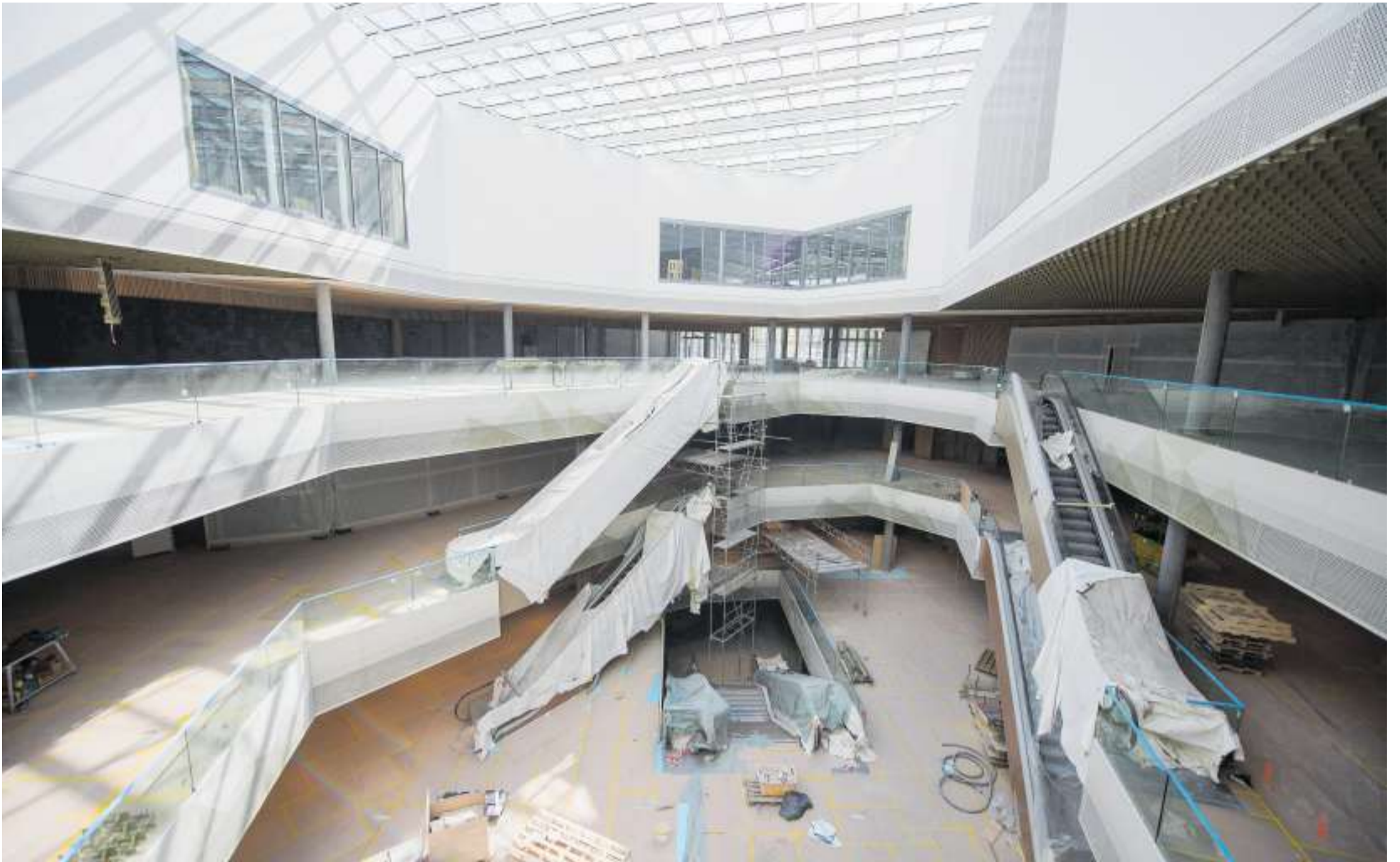
In Ebikon im Kanton Luzern entsteht das zweitgrösste Einkaufszentrum der Schweiz. Die Mall of Switzerland soll im November mit einer grossen Party eröffnet werden.
